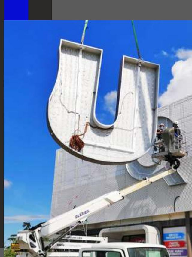
Lettere scatolari Qui Centro del colore di grande formato abbinato ai lati da 2 box luminosi riproducenti il marchio di fabbrica. Il cablaggio a led è stato realizzato con led tono su tono per un effetto luminoso notturno più intenso ed accattivante.
