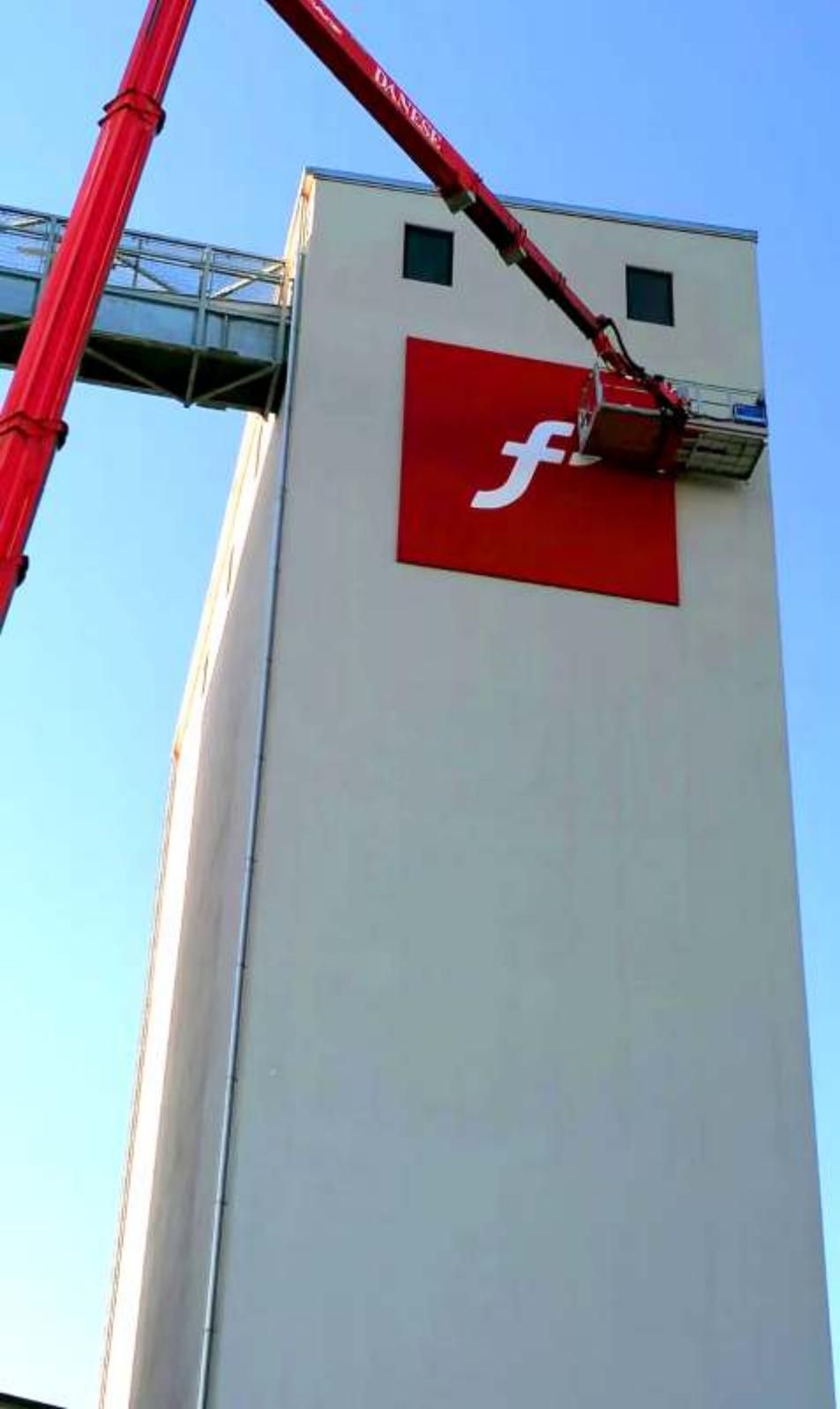
Insegna a doghe in alluminio complete di sottostruttura metallica. Risultato pulito ed efficace, garantito contro le deformazioni termiche, tipiche delle insegne di grande formato
