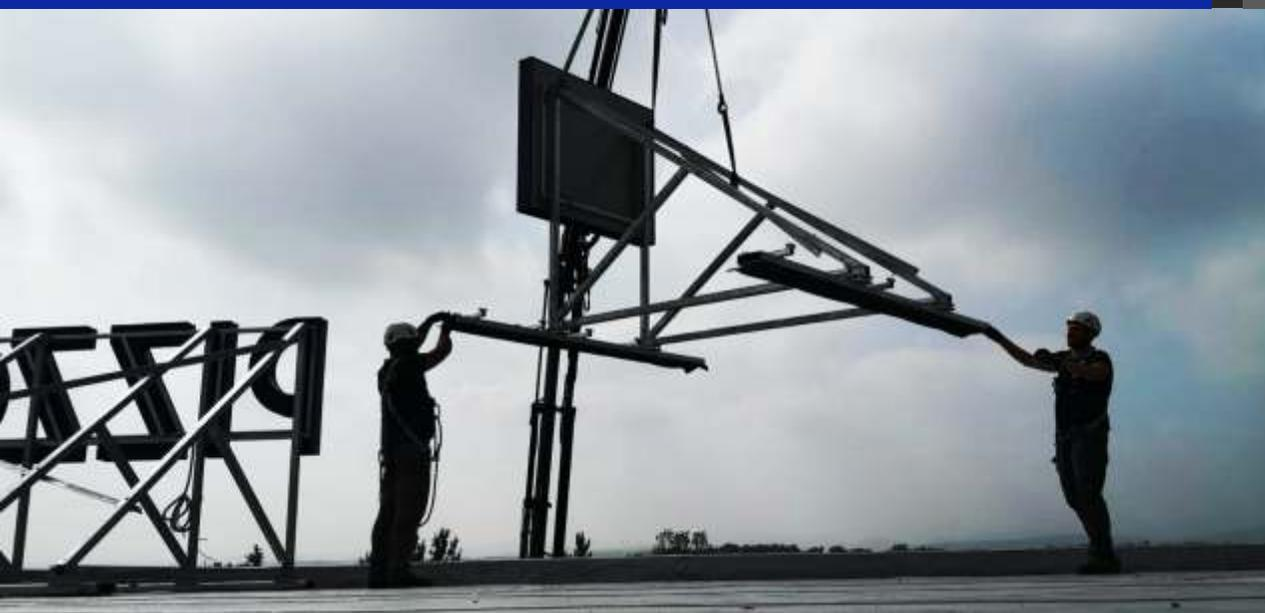
Lettere scatolari in alluminio a luce diretta con particolare sistema di fissaggio aereo specifico per gli edifici la cui copertura non consente fori di fissaggio
